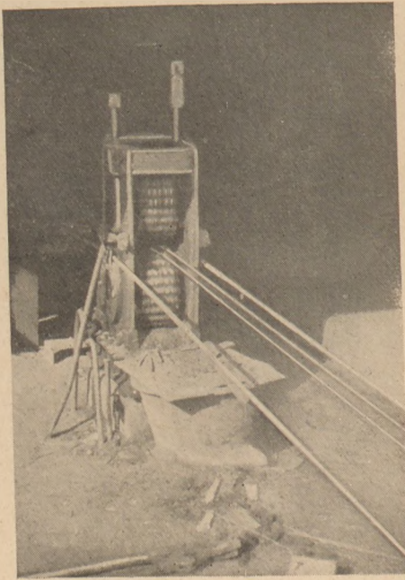
14. ábra. Huzalt hullámosító berendezés (fénykép)
