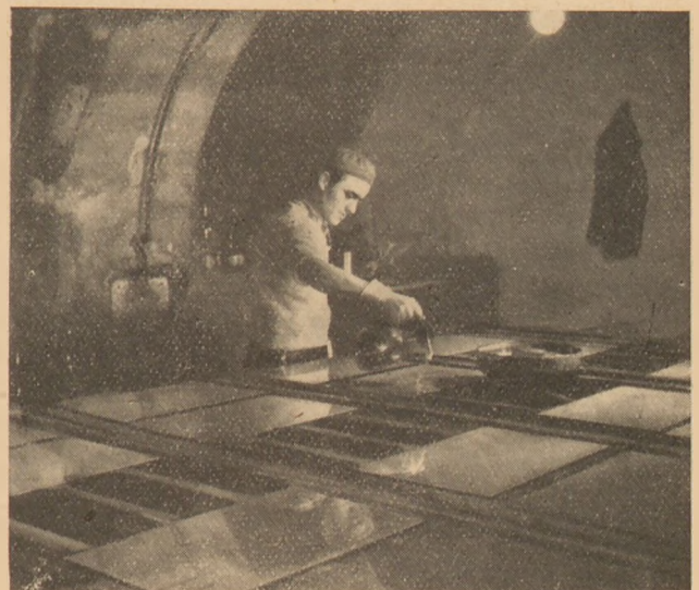
1. kép. Tükörkészítés állóasztalon. (Tükör- és Síküveg-csiszoló V.)
