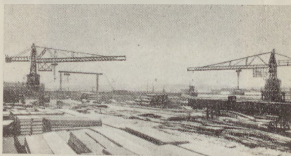
1. ábra. 1. sz. Épütelelemgyár. Tárolóhely toronydarukkal
