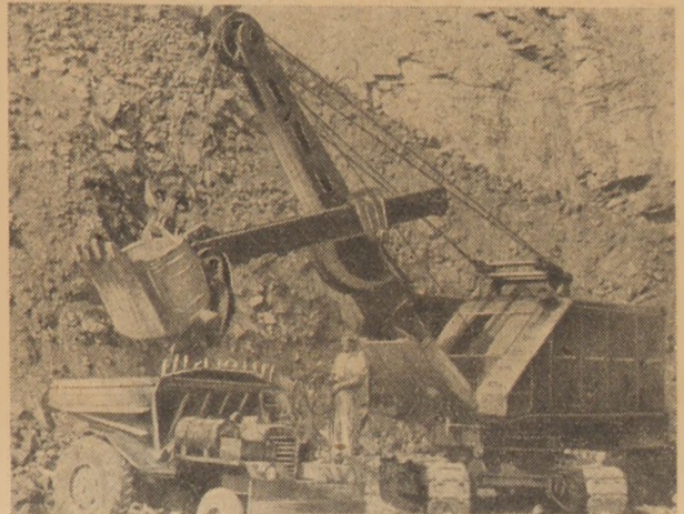
12. ábra. Exkavátor terméskövet rak dumperbe
