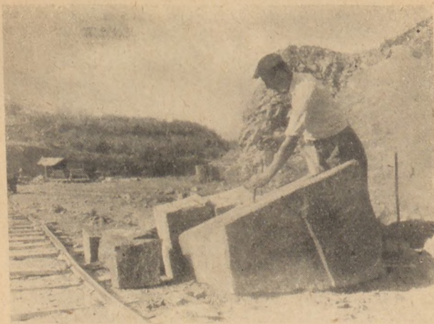
17. ábra. Kőhasítás útburkolókőhöz
