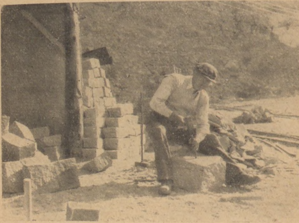
16. ábra. Faragott útburkolókő készítés
