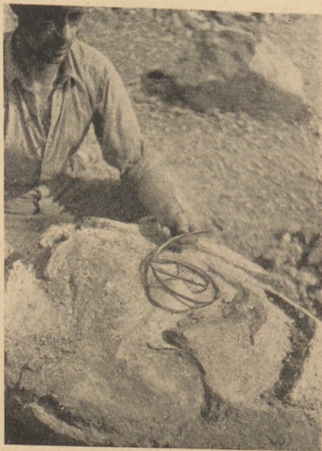
11. ábra. Formázott töltettel aprított kőtömb robbantás előtt
