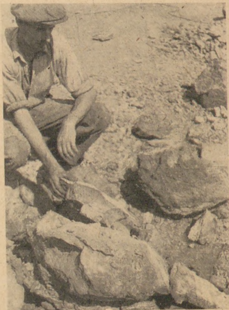
11. ábra. Formázott töltettel aprított kőtömb robbantás előtt
