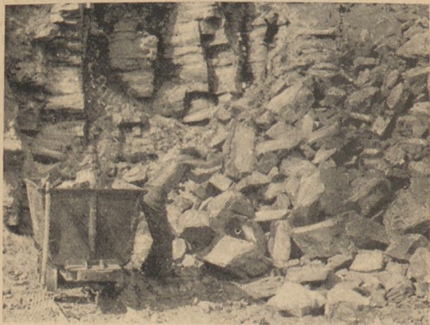
10. ábra. Bunkózással való aprítás
