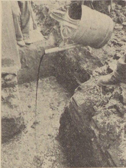
22. ábra. Biológiai hatású védő agyaggal építése Budapesten (Véssey felv.)
