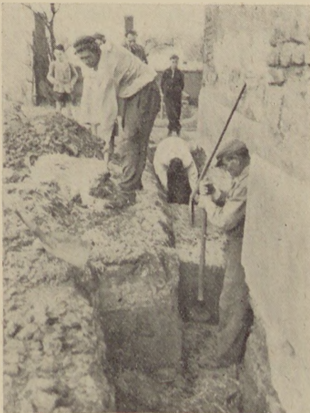
23. ábra. Agyag beoltása szulfátredukáló baktériumokkal (Véssey felv.)
