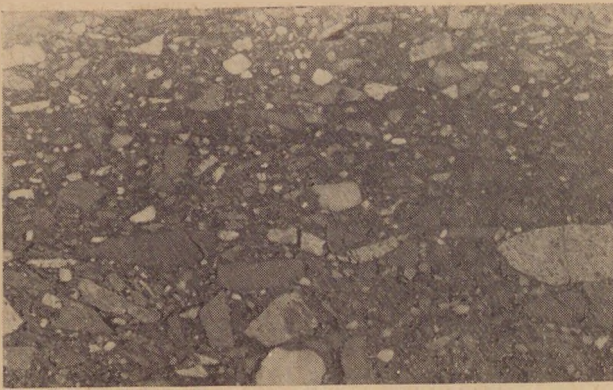
11. ábra. Háromrétegű aszfaltbeton útburkolat keresztmetszete: a két felső réteg zúzalékos finom aszfaltbeton, az alsó teherátadó réteg (binder). A teherátadó rétegben a hosszúkás zúzalékszemesek aprózódása jól látható
