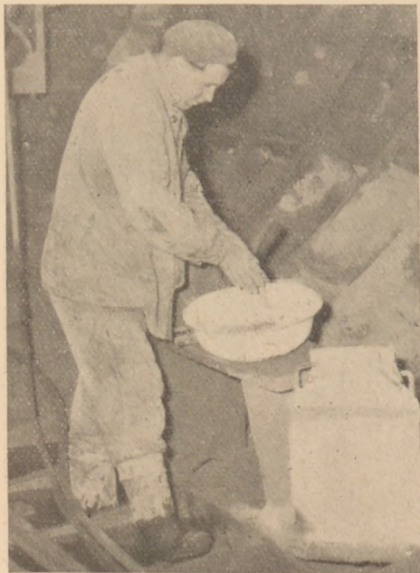
25. ábra. Duzzadócement keverése
