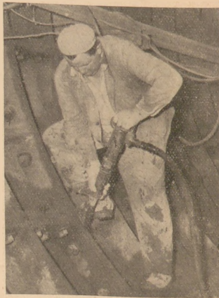
26. ábra. Duzzadócement tömörítése pneumatikus kalapáccsal
