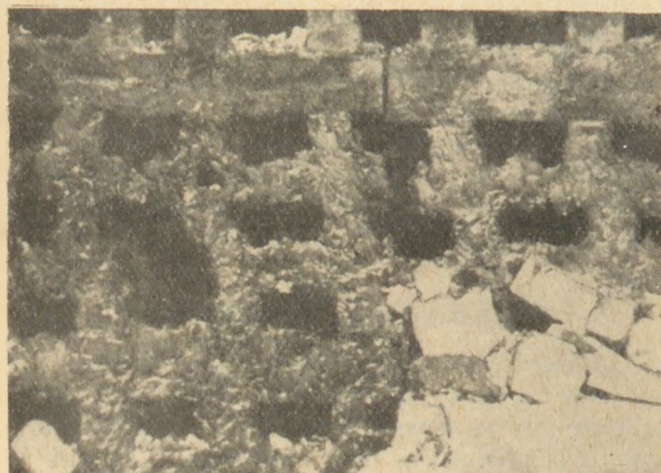
1. ábra. Nagy szemcseméretű krómérc adalékos téglából épített SM-kemencerácsozat egy kemenceperiódus befejezése után
