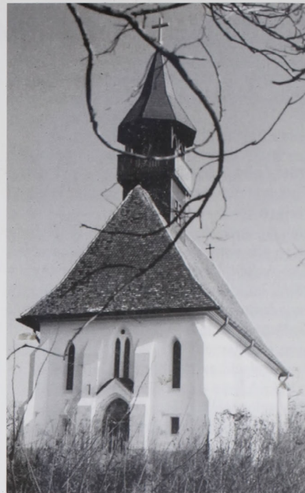
Az óföldeáki templom a helyreállítás közben, 1998-ban – The church of Óföldeák during reconstruction
