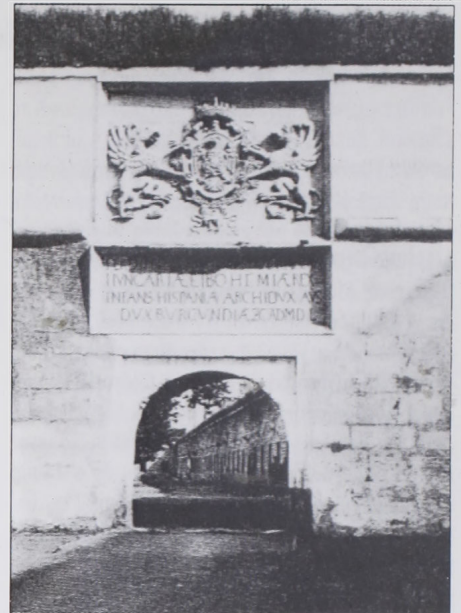
A Óregvár főbejárata, az ún. Ferdinánd-kapu – Entrance to the Old Castle, the so called Ferdinand Gate
