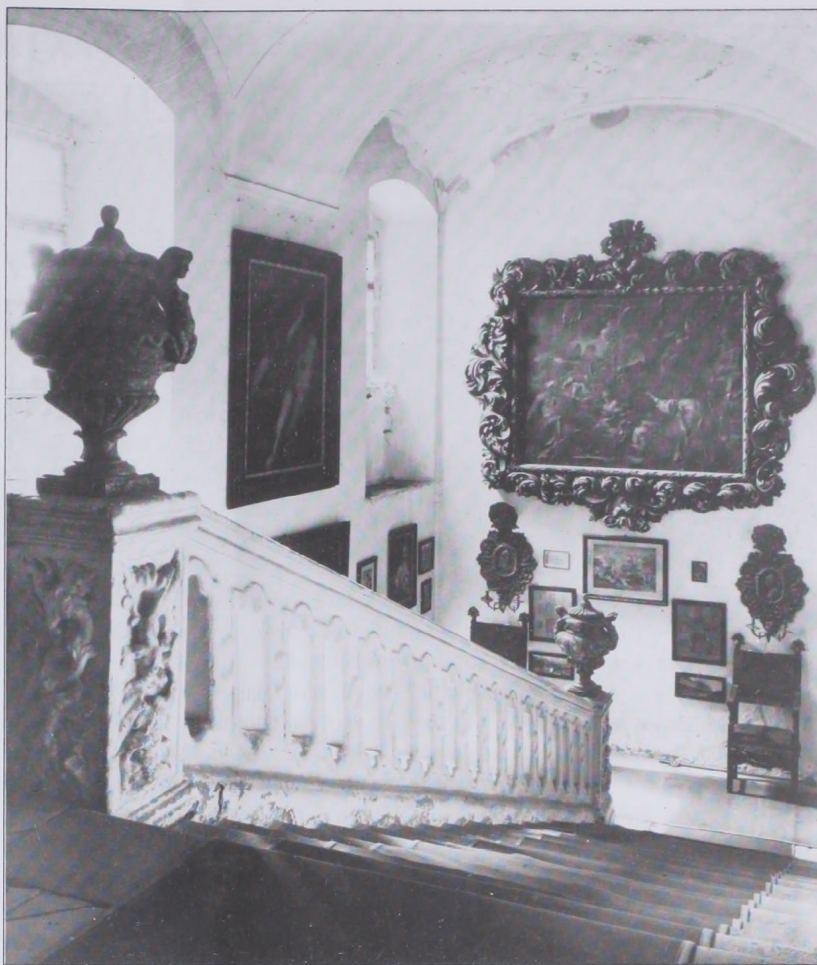
Az Óbuda-Kiscelli trinitarius kolostor lépcsőháza – Staircase of the Óbuda-Kiscell monastery
