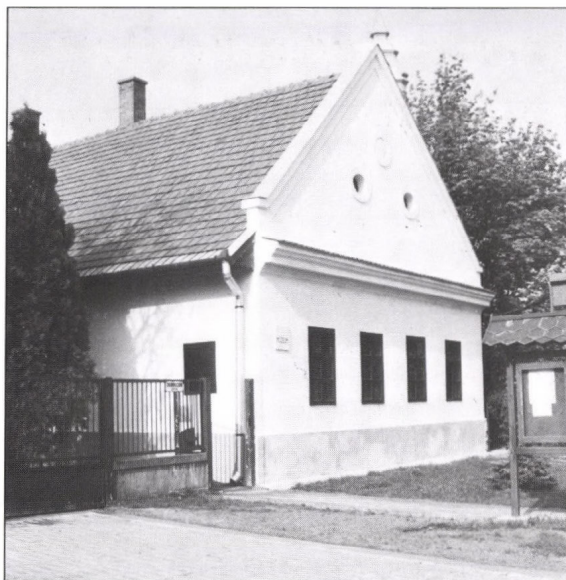
A múzeum utcai homlokzata The street facade of the museum
