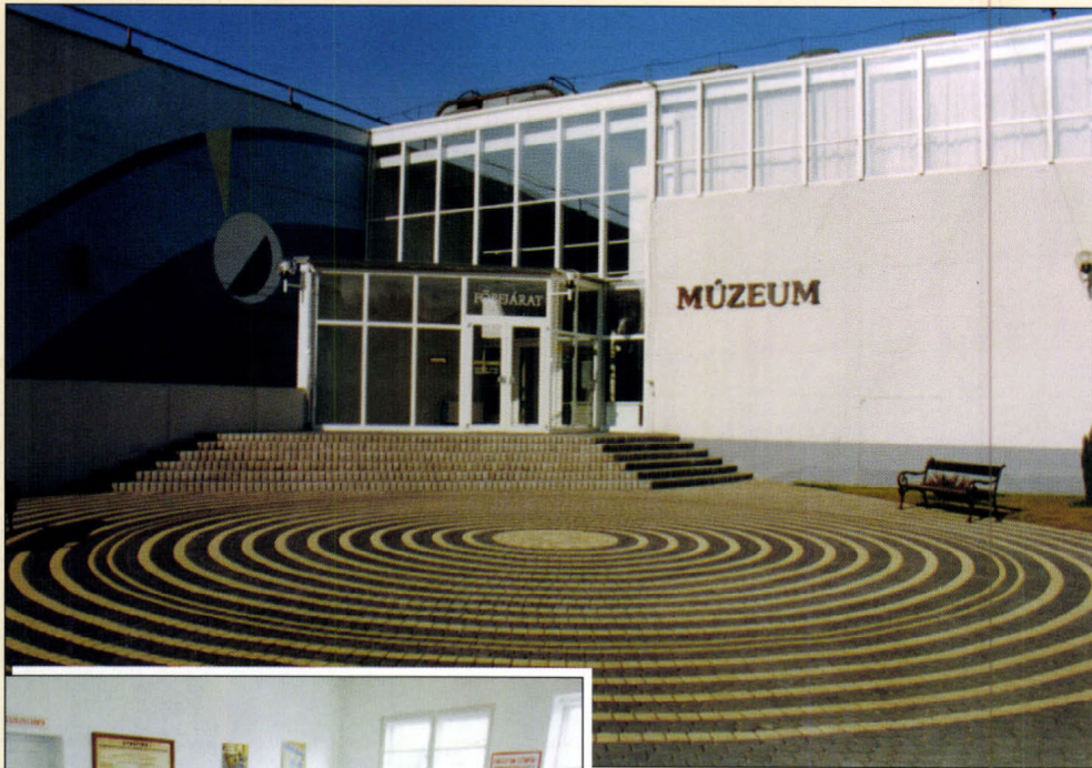
A felújított Tatabányai Múzeum épülete The renovated building of the Tatabánya Museum
