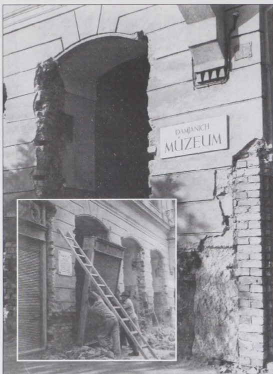
A földszint átalakítása, 1954 Rebuilding of the ground floor
