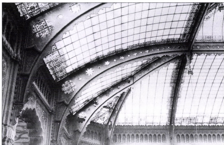
A nagycsarnok részlete az eredeti színes üvegszegéllyel, ill. az áttört vastartók festett díszítésével – Detail of the Great Hall with the original coloured glassframes and painted decoration of the iron supports
