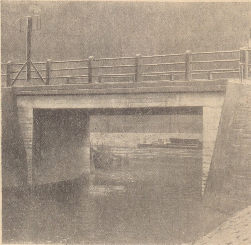
12. ábra. Stabilizált nagy MgO-tartalmú portlandcementből készült vasbeton hídszerkezet
