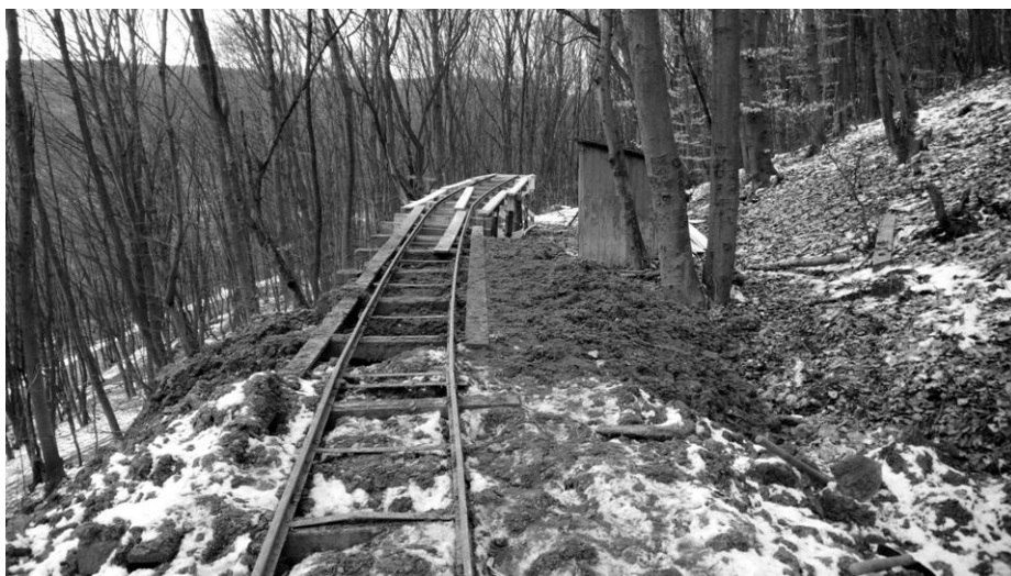
14. ábra: A nagy mennyiségű hordalékot és a meder mélyítésből felszabadult kőzetanyagokat ideiglenes sín pár kiépítésével, kézi erővel történő mozgatással juttatták a felszínre Fig. 14. Arge amounts of sediment and rock material released from the dredging have been brought to the surface by the construction of a temporary shingle, manually moved
