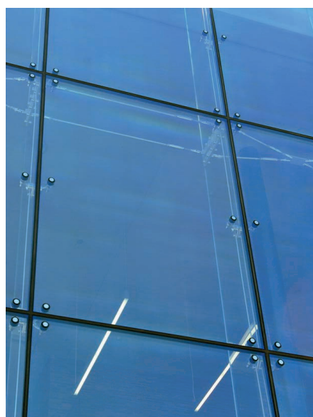
15. ábra Anizotrópia megjelenése, Zenei központ üveg homlokzata, Helsinki Fig. 15. Appearance of anisotropy in glass facade of Music Centre in Helsinki
