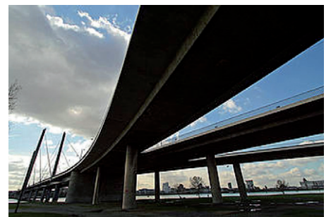
Rheinkniebrücke in Düsseldorf, Germany
