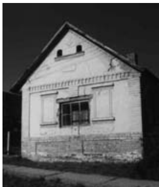
5. ábra Rosszul átalakított épület Nagyszékelyen Fig. 5. Badly transformed building in Nagyszékely
