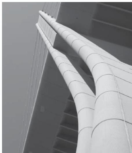
Többtámaszú, ferdekábeles híd Y-alakú pilonokkal és S-alakú alaprajzi vonalvezetéssel, Ammán (Jordánia)
