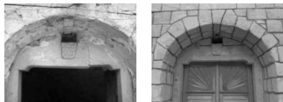
4. és 5. ábra: Felújítás előtt és után Fig. 4. and 5. Before and after renovation
