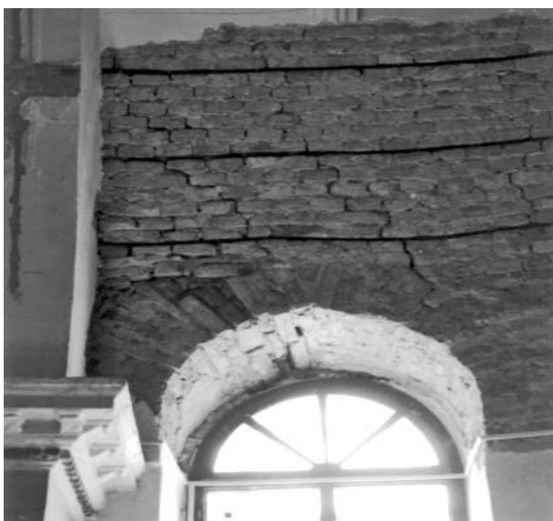
8. ábra. Repedésöltések Fig. 8. "Stitching" of cracks
