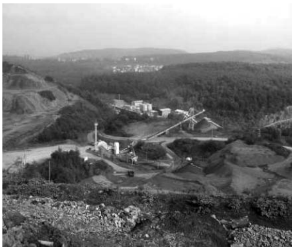
5. ábra. A Komló II.-andezit védnevű bánya és a Gesztenyész-lakótelep Fig. 5. Andesite quarry denominated as Komló-II.-andezit and housing estate Gesztenyész
