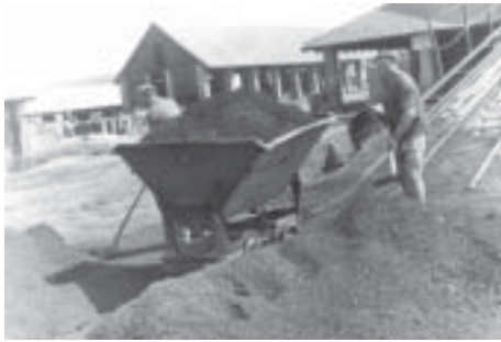
A szénpor feljuttatása a körkemence tetejére
