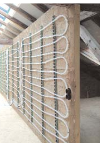
Falfűtés készítés közben a tetőtérben
