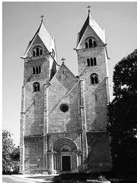
11. kép. A nyugati homlokzat mai képe a tornyok háromszög-ormozataival és a csürlős sisakkokkal
