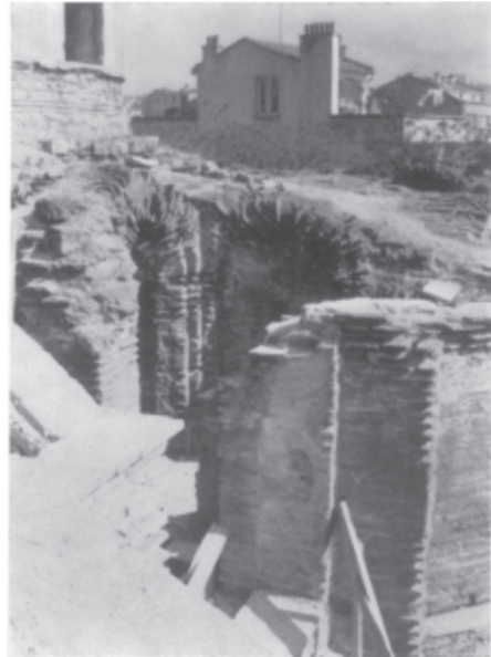
XXX. Theotokos tou Libos, az egyik mellékkupola tartószerkezetének maradványai
