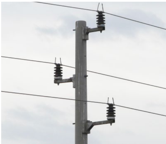
A régió néhány 20 kV-os oszlopa (fotó: Petar Iankov) 20 kV pylon types from the region
