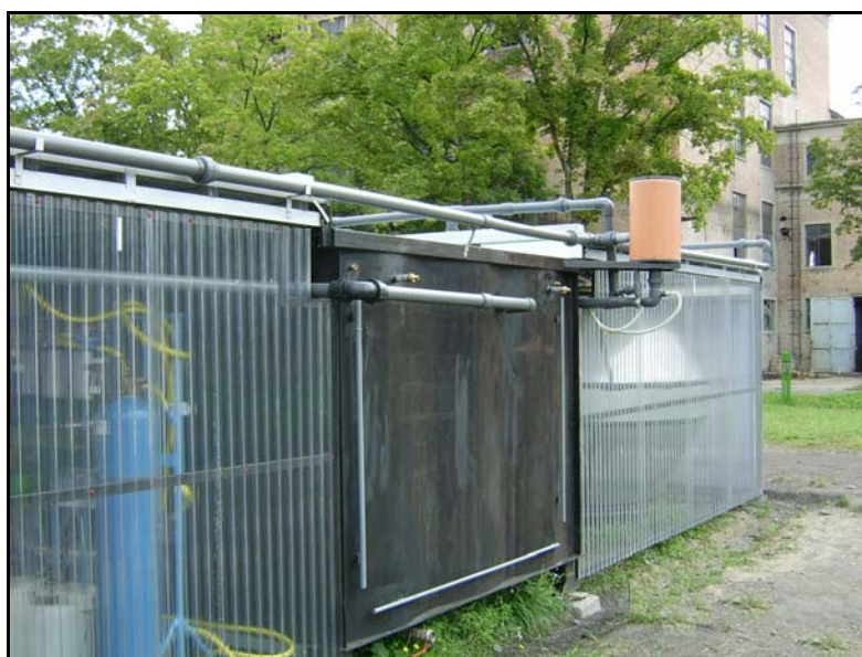
A talajvíz tisztítására Hidason felépített 50 m 3 /nap kapacitású referenciaüzem
