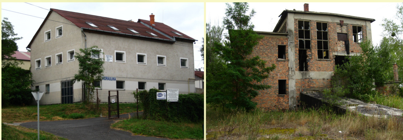
2. ábra: Egykori üzemi épületek rehabilitált és romos példái egymástól 100 méterre Padragkúton. Forrás: Sókuti Zs. fényképe
