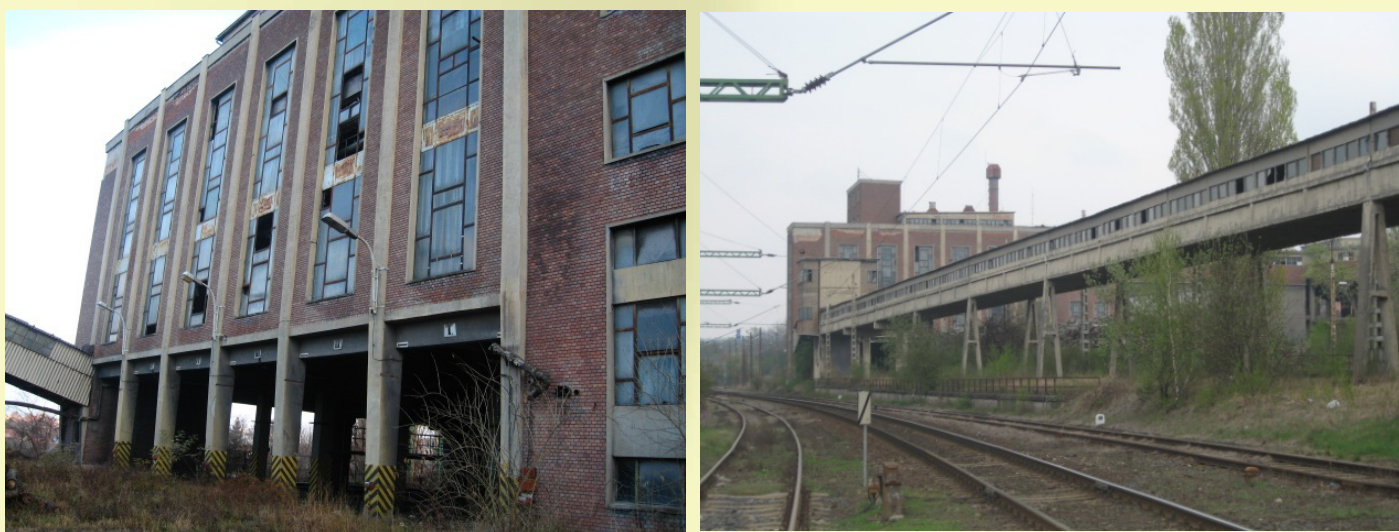
5. ábra: A központi szénosztályozó és az erőműbe vezető szalaghíd Forrás: Sókuti Zs. fényképe
