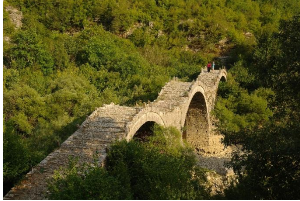
11. ábra: Háromlyukú kőhid Zagoriban Fig. 11: Triple arched stone bridge in Zagori
