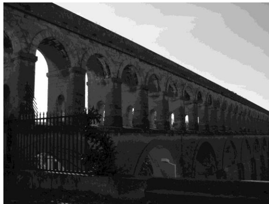
4. kép.Felszíni vízvezeték Montpellierben Picture 4. Aqueduct in Montpellier (original)
