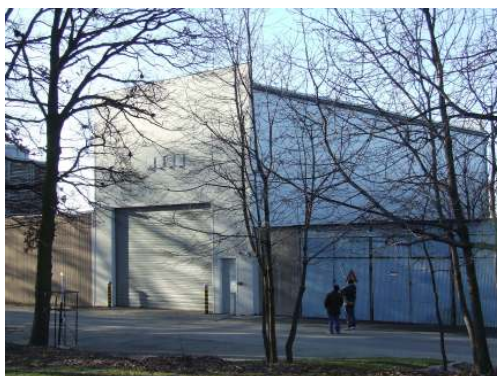
1. ábra. Az új KKFT épület
