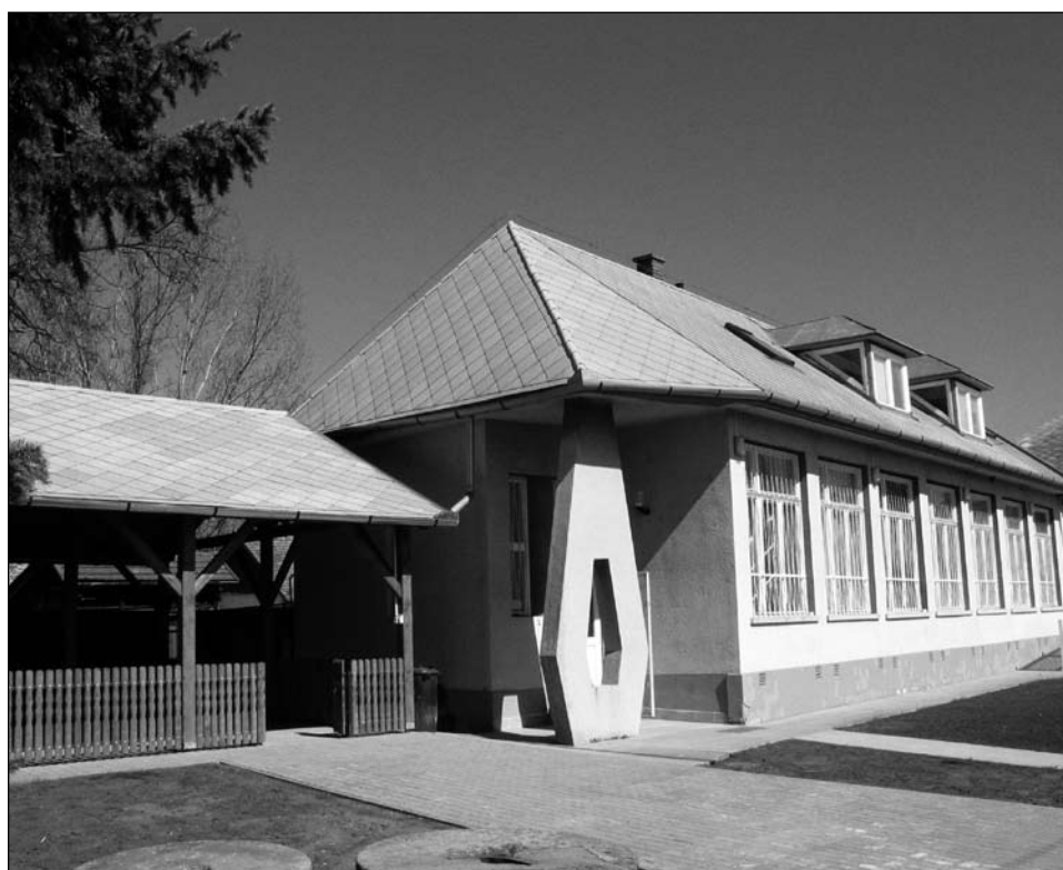
A múzeum a tetőbeépítés után The museum after the remodelling of the roof
