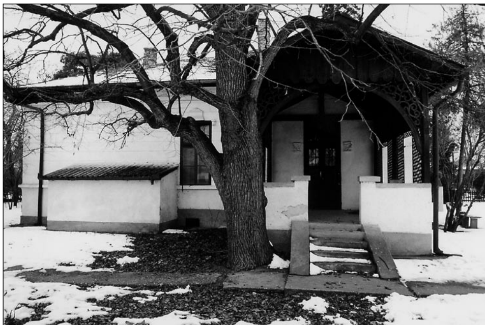
Bartók Béla egykori lakóháza a felújítás előtt Béla Bartók's former home, before and after renovation Fotó – Photo: Szántó György
