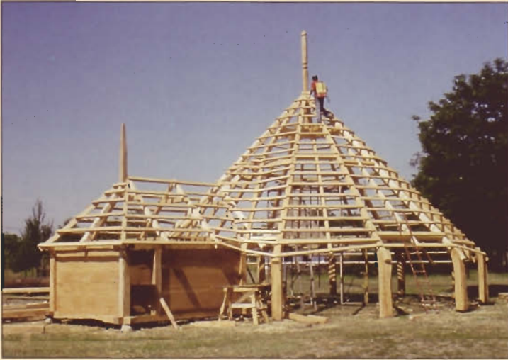
A matolcsi szárazmalom építés közben a Sóstó Múzeumfaluban The horse-driven mill from Matolcs under construction at the Sóstó Village Museum Fotó – Photo: Páll István
