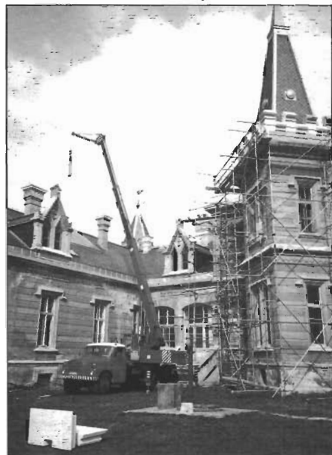
A nádasdladányi Nádasdy-kastély helyreállítás közben, 1999 The Nádasdy manor-house in Nádasdladány under reconstruction Fotó – Photo: Ónódi Szabó Lajos
