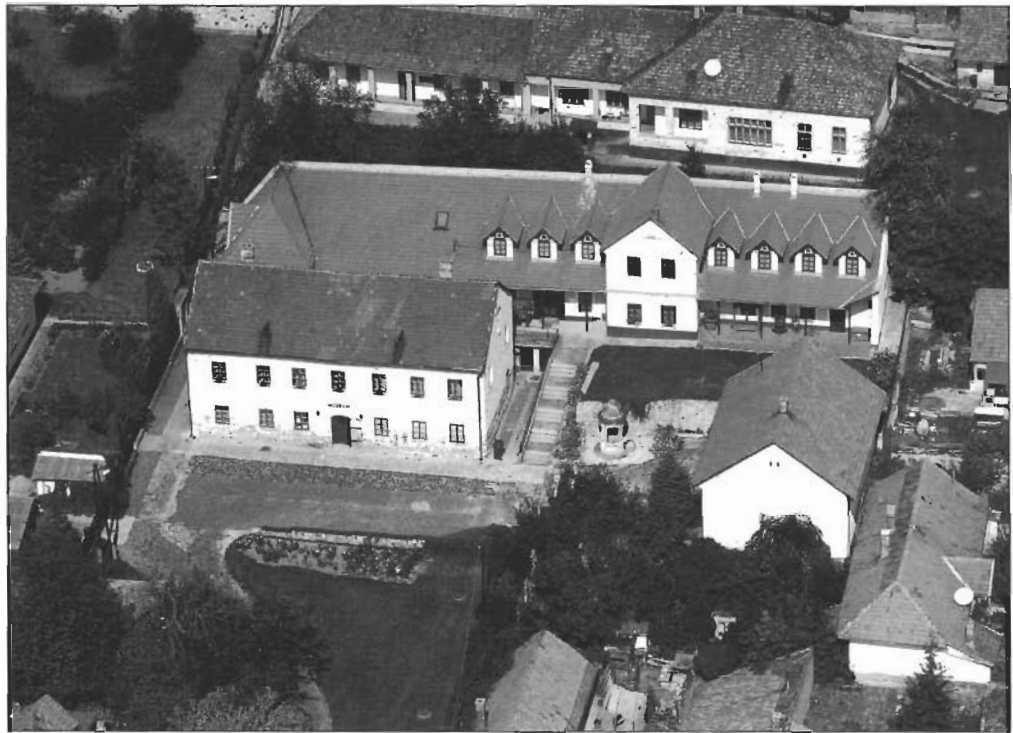
Az aszódi Petőfi Múzeum épülete, 1999 The building of Petőfi Museum in Aszód, 1999
