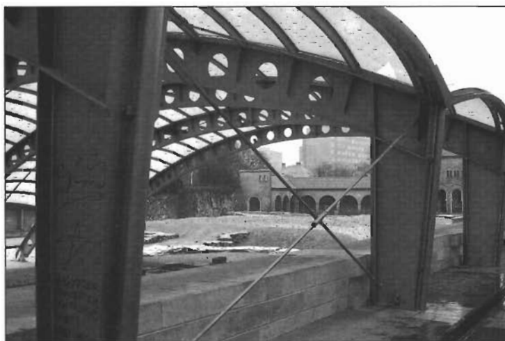
Az acélszerkezet részlete a mauzóleum felé néző látvánnyal, 2001 Detail of the steel construction with a view on the mausoleum, 2001 Fotók – Photos: Papp Mónika
