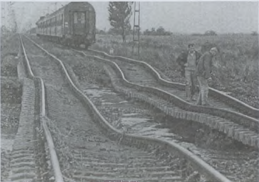
Az elmosott alépítmény Nagyút és Kál-Kápolna között 1999-ben
