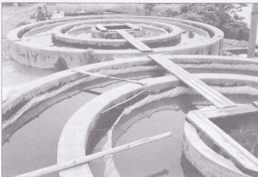
A keltetés az amur- és busafajok esetében betonból készült halkeltető medencékben történik, amelyekben a körkörösén áramló víz tartja lebegésben az ikrát
