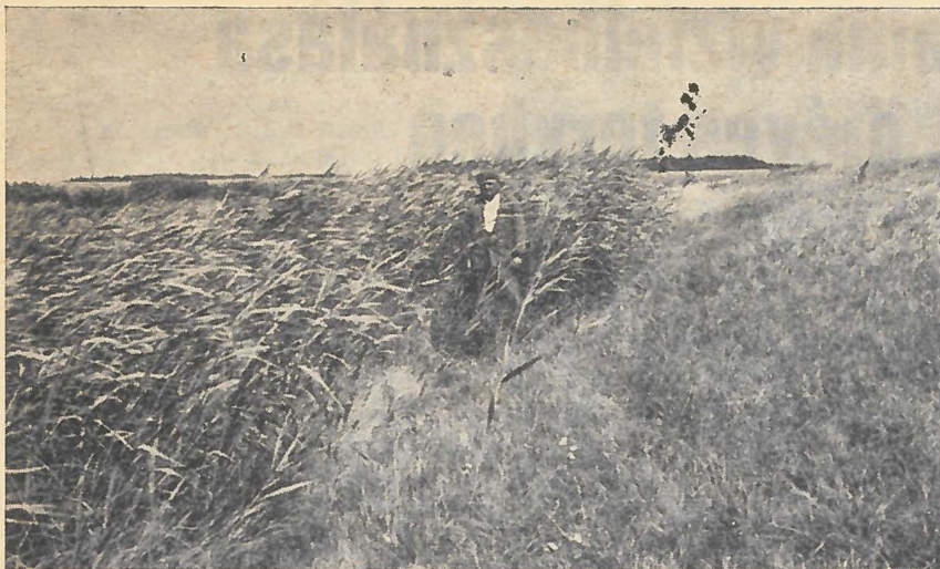
A hullámok kioltása visszaverődés nélkül, fokozatosan megy végbe; a gyepes részt már nem érik el
