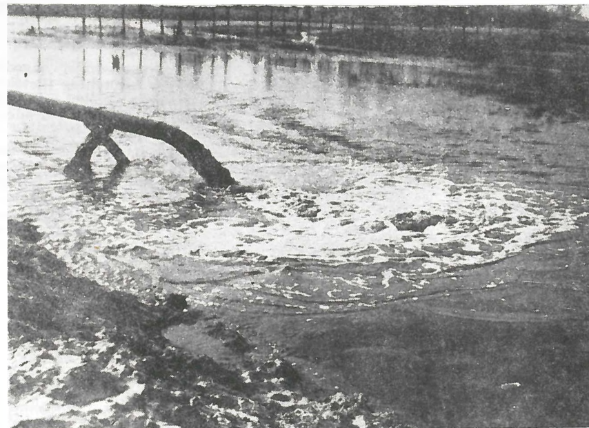
A szennyvíziszap eltávolítása kotrással
