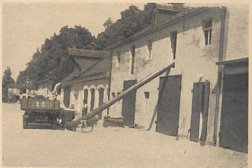
Takarmányfúvó berendezéssel juttatják fel a haltakarmányt a magtár felső emeletére a königs-warthai halgazdaságban
