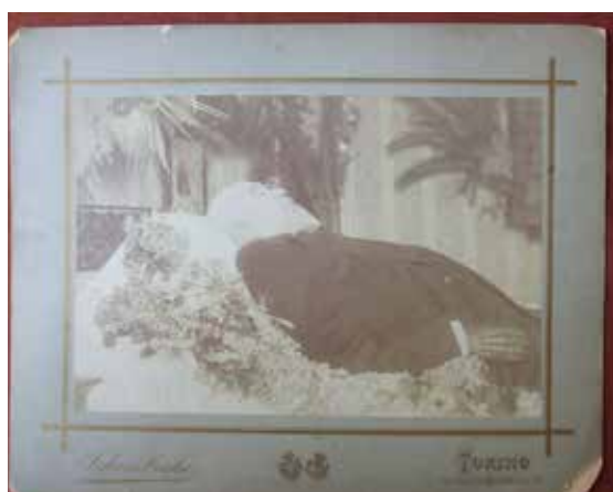
14. Szakadt, hiányos papírkeret
