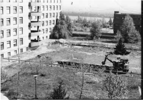
A D-szárny építése
