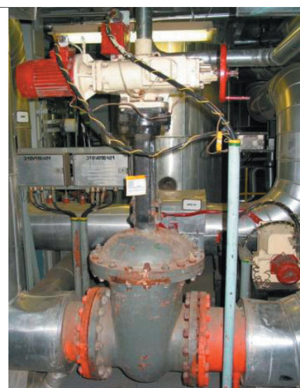
Motoros tolozár felépítése és képe
