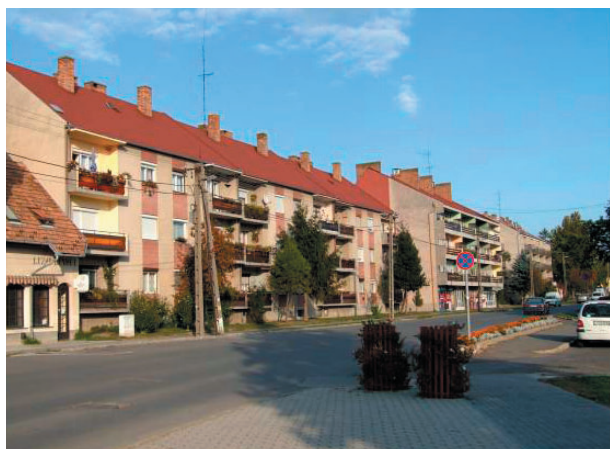
2. ábra. A vizsgált lakóépületek
