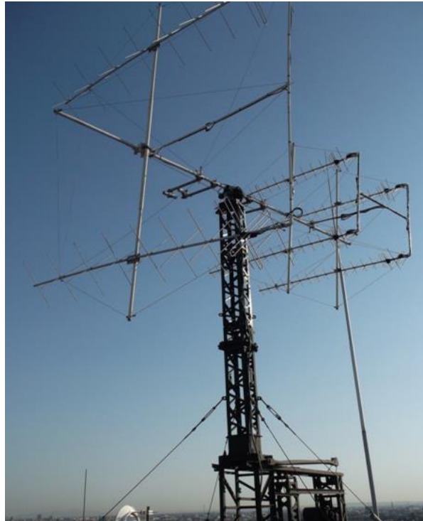
14. ábra Az antennarendszer a forgatóval
