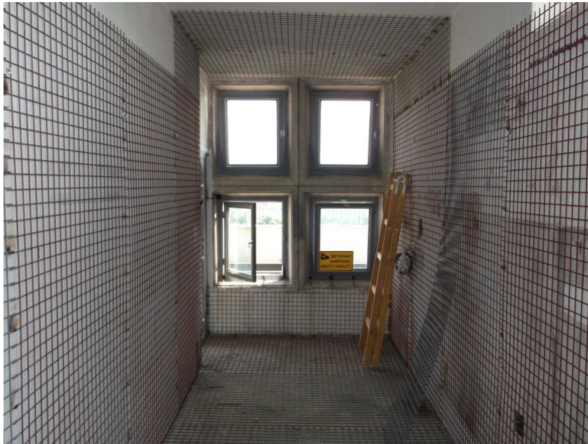
8. ábra A bemutató állomás helyisége a Faraday-kalickával
