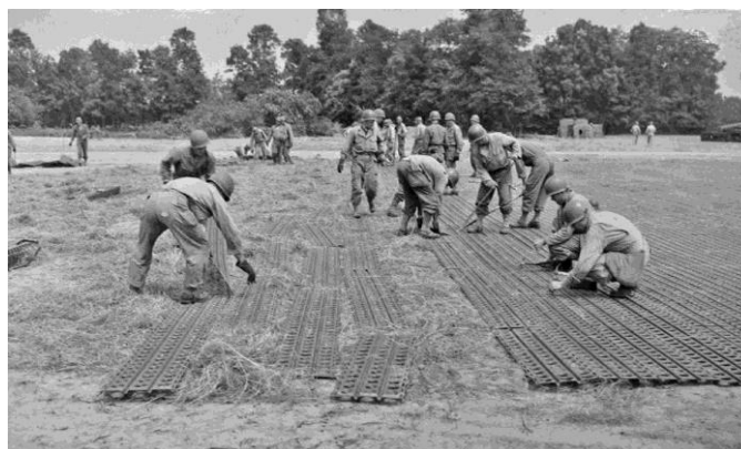
7. ábra A le- és felszállópálya építése 17
