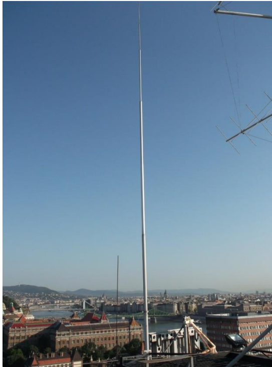
7. ábra A villámvédelmi levezető
