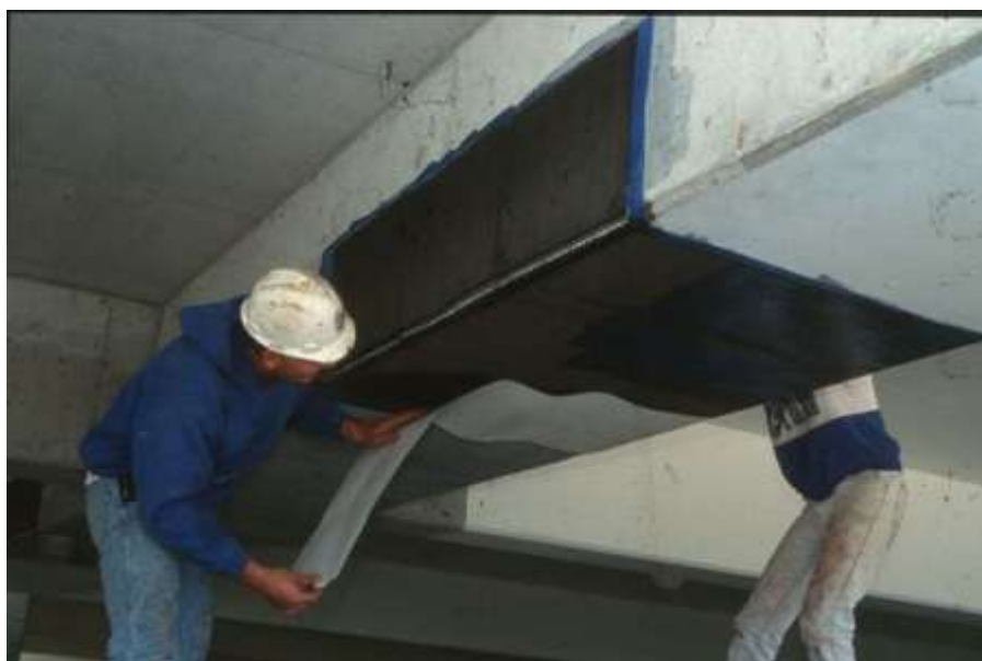
11. ábra Tartószerkezet szénszálas megerősítése 16
