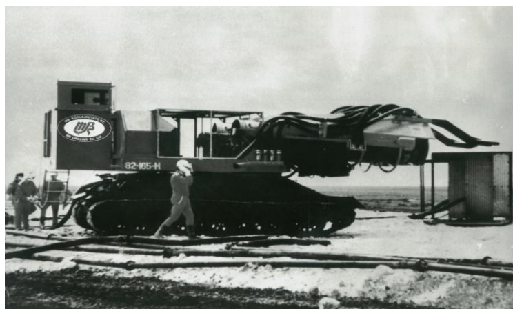
3. ábra. MIG-21 — szuperszonikus sugárhajtású repülőgép — hajtóművével épült turbóreaktív oltógép, azaz a „ Big Wind ”, a „ Tüzoltó páncélos ”, „ Páncélos tüzoltó ”, vagy Kút(tűz)ölő ”.
