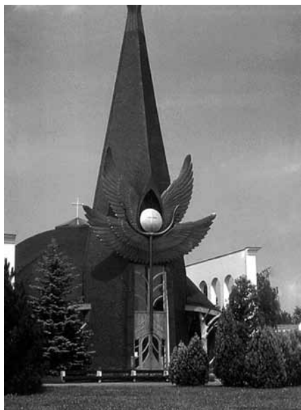
Fig. 5. Chiesa di Santo Stefano (Százhalombatta, 1995-1998). Prospetto principale.
