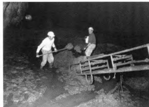
A csónakázató iszaptalanítási munkálatai
